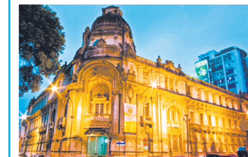
Patrimônio ameaçado pela instalação do uso comercial do prédio
