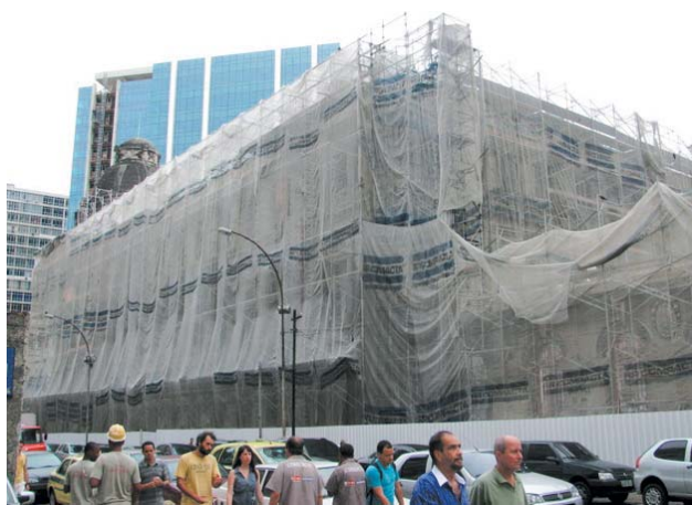
Tanto a fachada quanto o interior do prédio estão sendo restaurados
