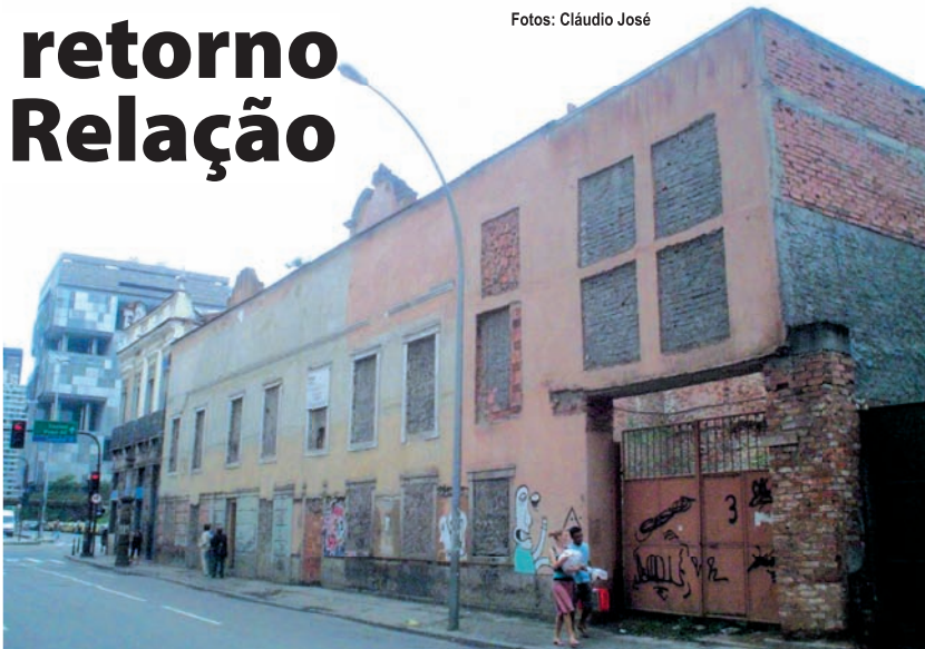
O Sinpol construiu toda fachada do prédio
