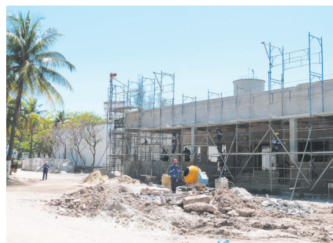
Obras adiantadas na Cidade da Polícia
